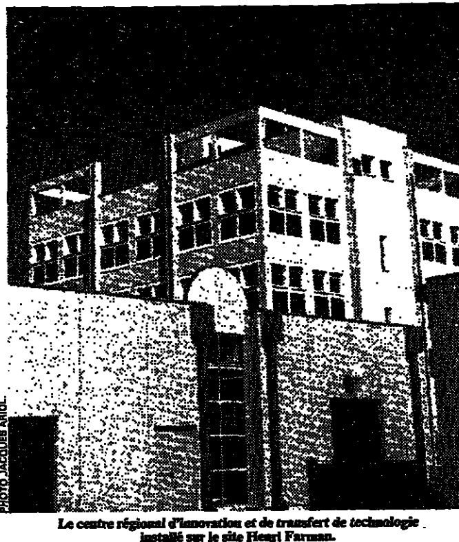
Le centre régional d'innovation et de transfert de technologie installé sur le site Henri-Farman.
